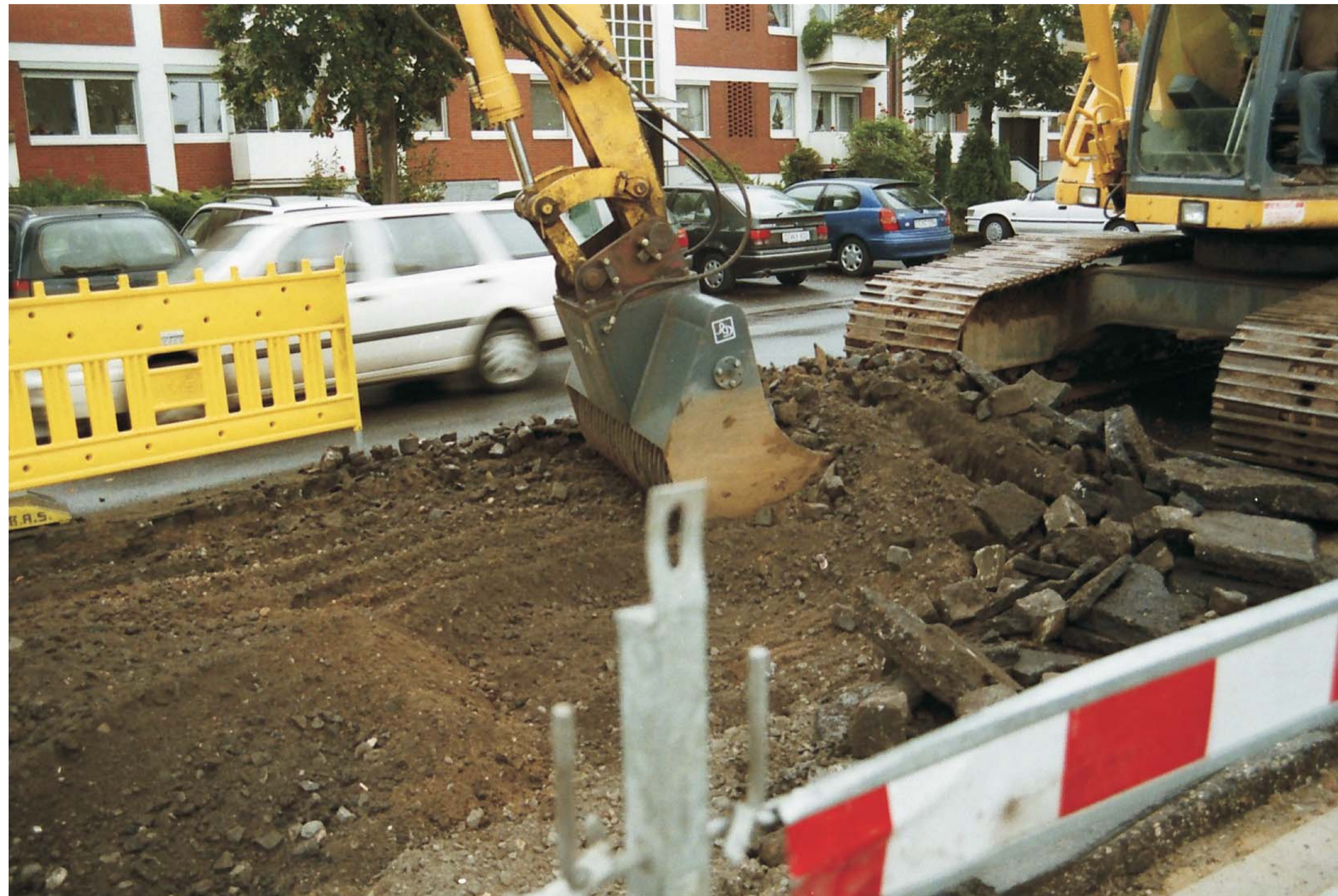
Abtransport von Straßenaufbruch - Unterbau bleibt vorhanden Siebschaufel: B34-1500-50 S - Bagger: Furukawa 635 LS
