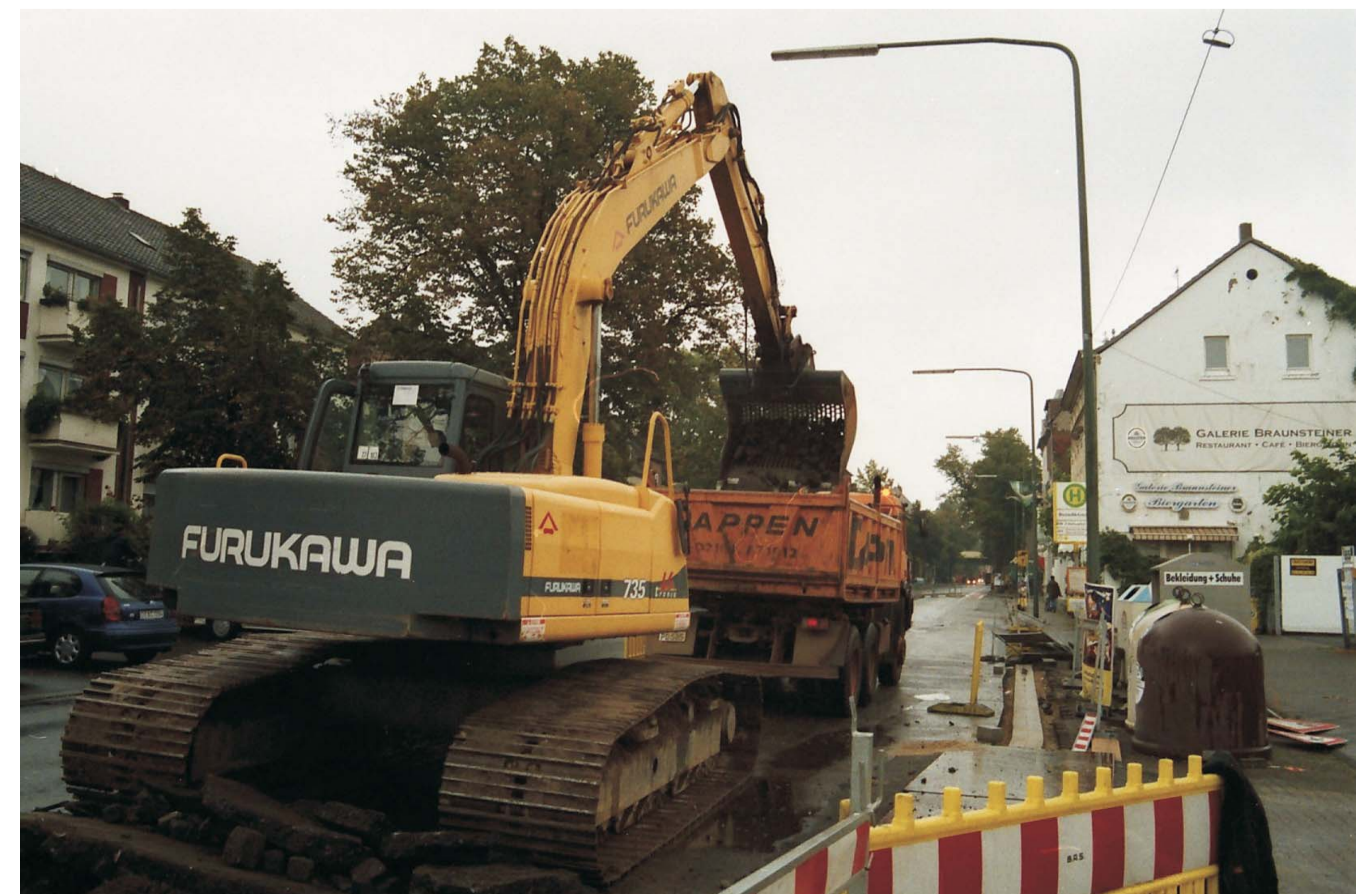
Abtransport von Straßenaufbruch - Unterbau bleibt vorhanden Siebschaufel: B34-1500-50 S - Bagger: Furukawa 635 LS
