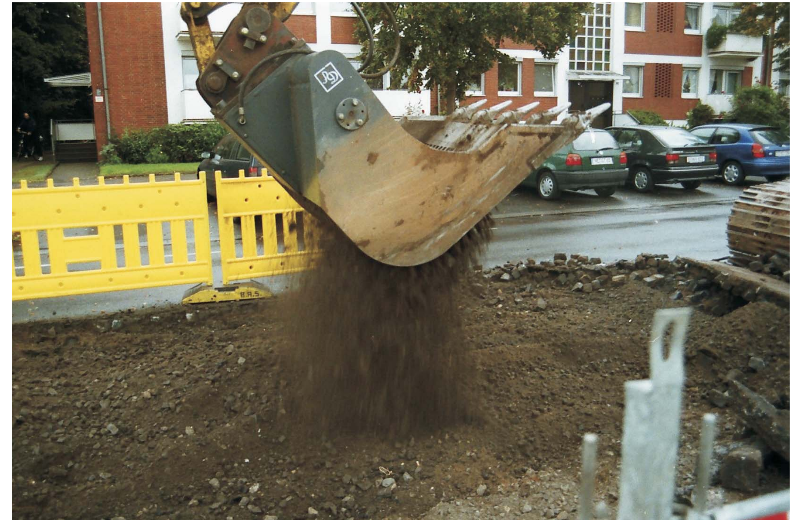
Abtransport von Straßenaufbruch - Unterbau bleibt vorhanden Siebschaufel: B34-1500-50 S - Bagger: Furukawa 635 LS
