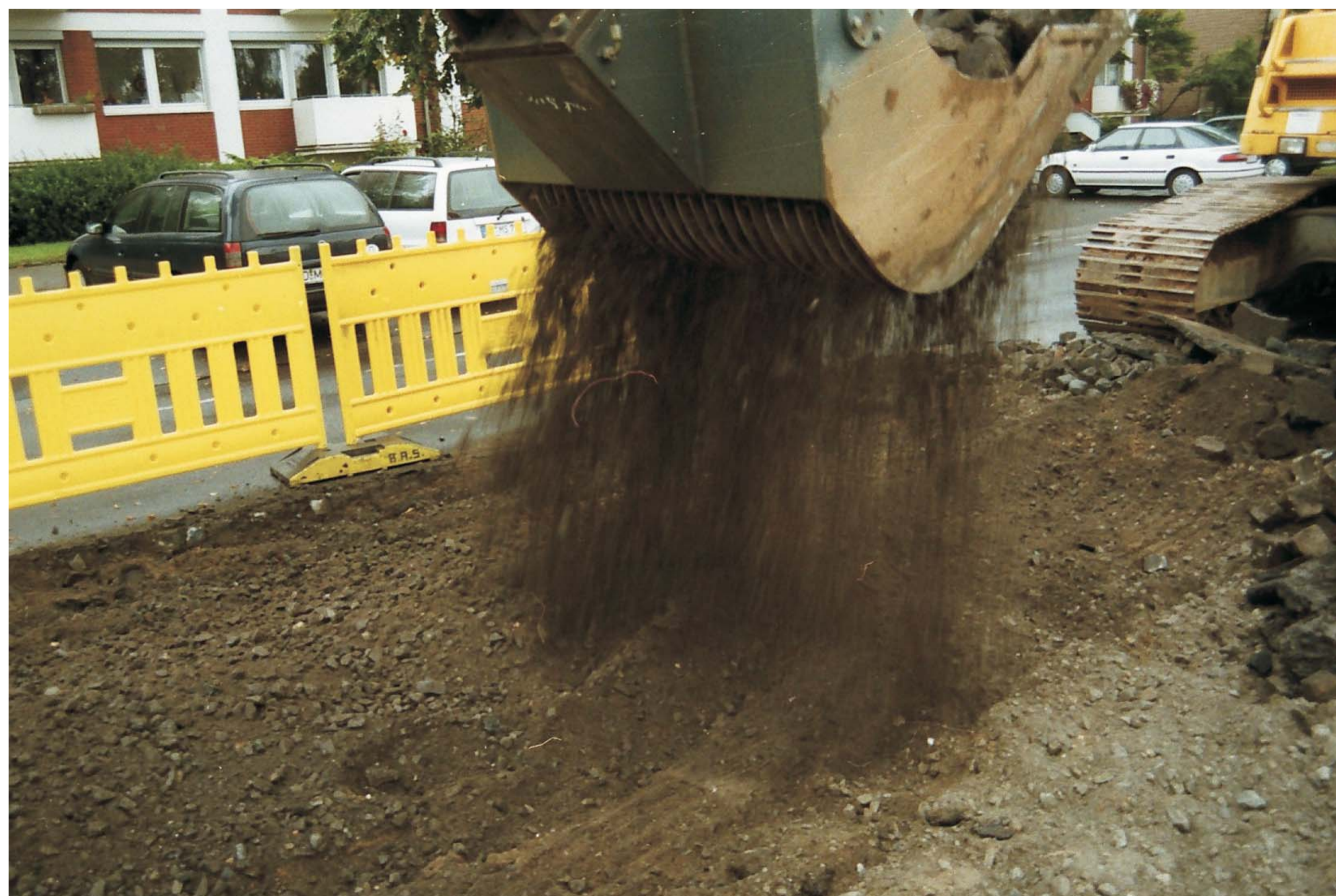
Abtransport von Straßenaufbruch - Unterbau bleibt vorhanden Siebschaufel: B34-1500-50 S - Bagger: Furukawa 635 LS
