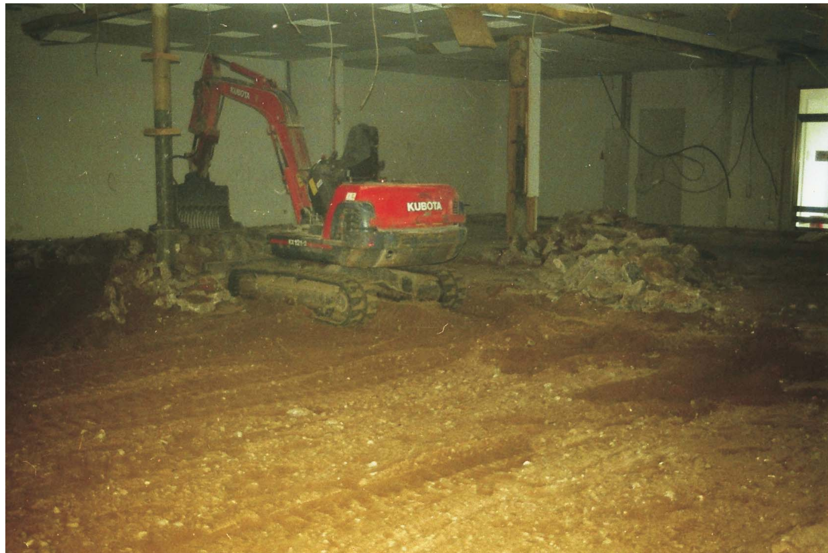
Betonboden einer Halle entfernt Siebschaufel: B18-800-30 - Bagger: Kubota KX 121-2
