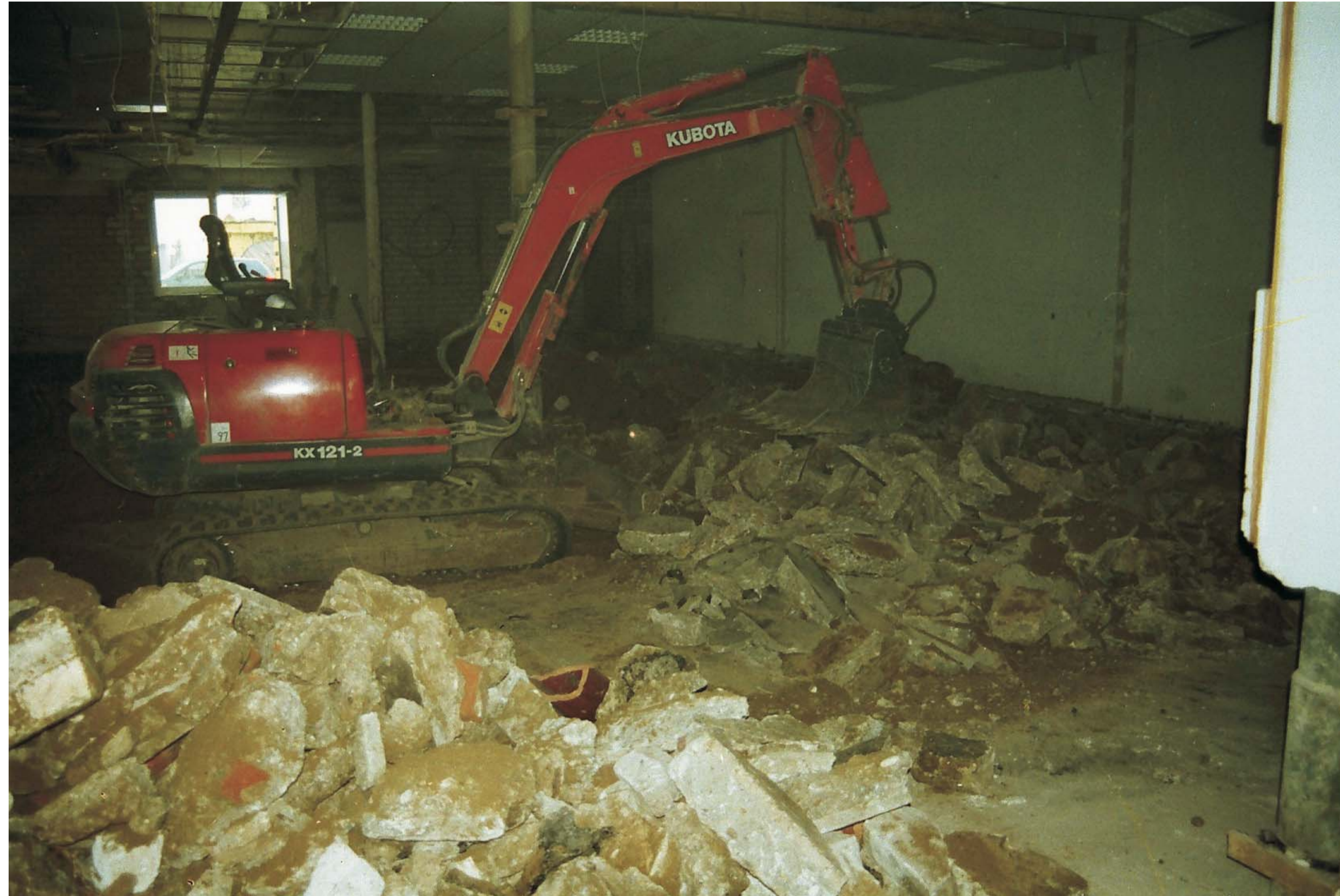
Betonboden einer Halle entfernt Siebschaufel: B18-800-30 - Bagger: Kubota KX 121-2
