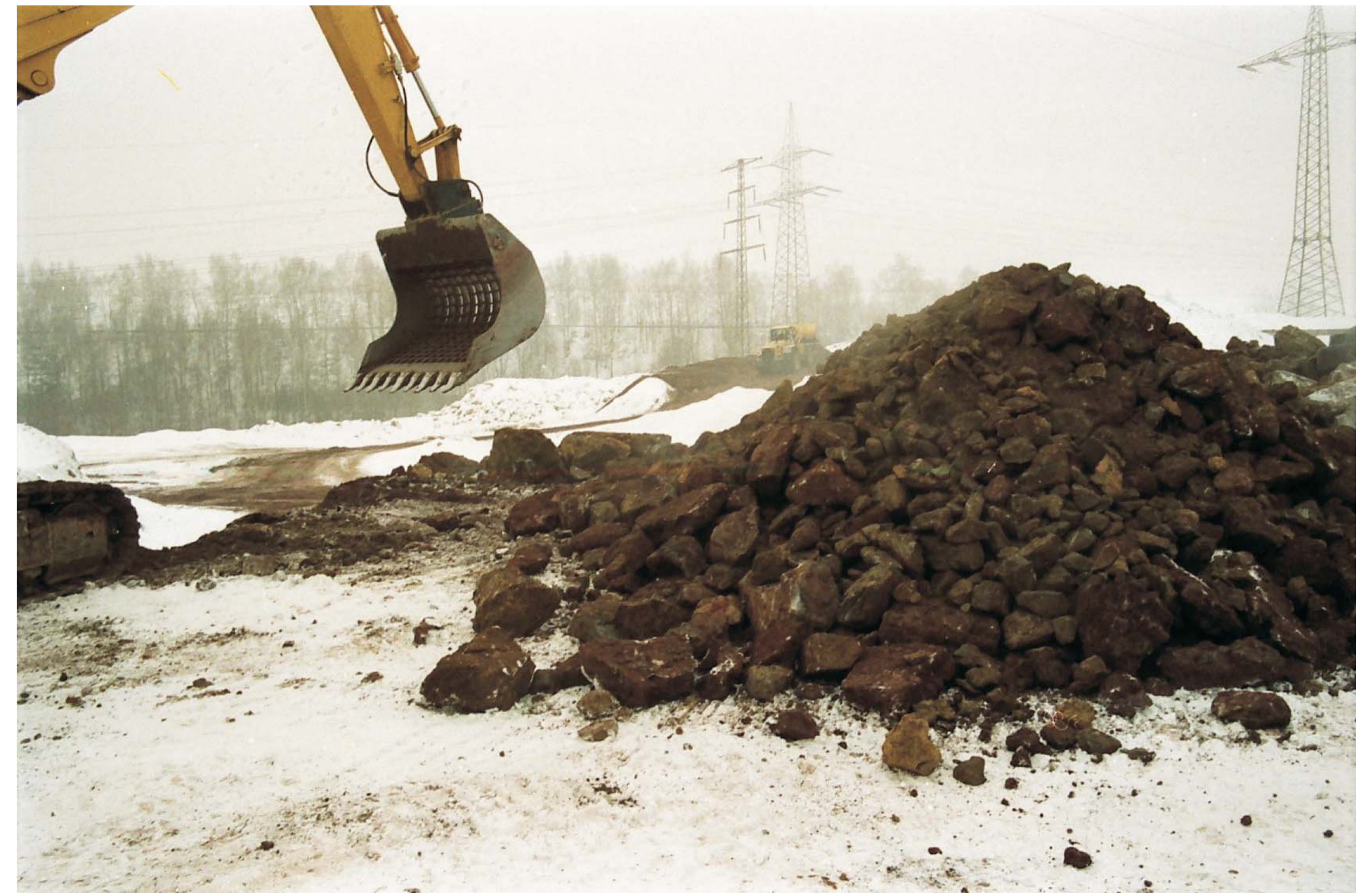
450.000 m 3 Tunnelaushub gesiebt Siebschaufel: 2x B44-1500-100 S - Bagger: Komatsu Pc290
