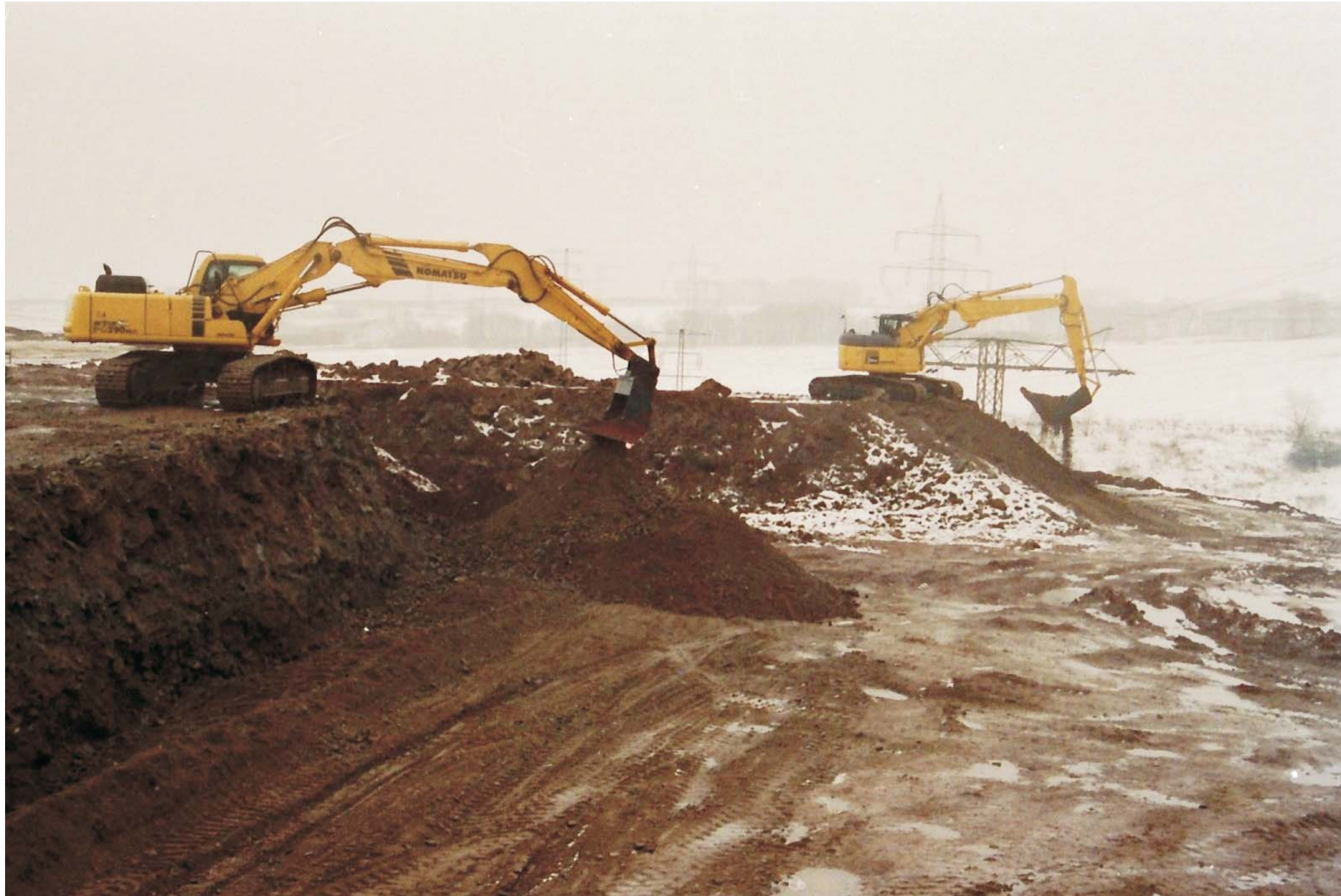
450.000 m 3 Tunnelaushub gesiebt Siebschaufel: 2x B44-1500-100 S - Bagger: Komatsu Pc290
