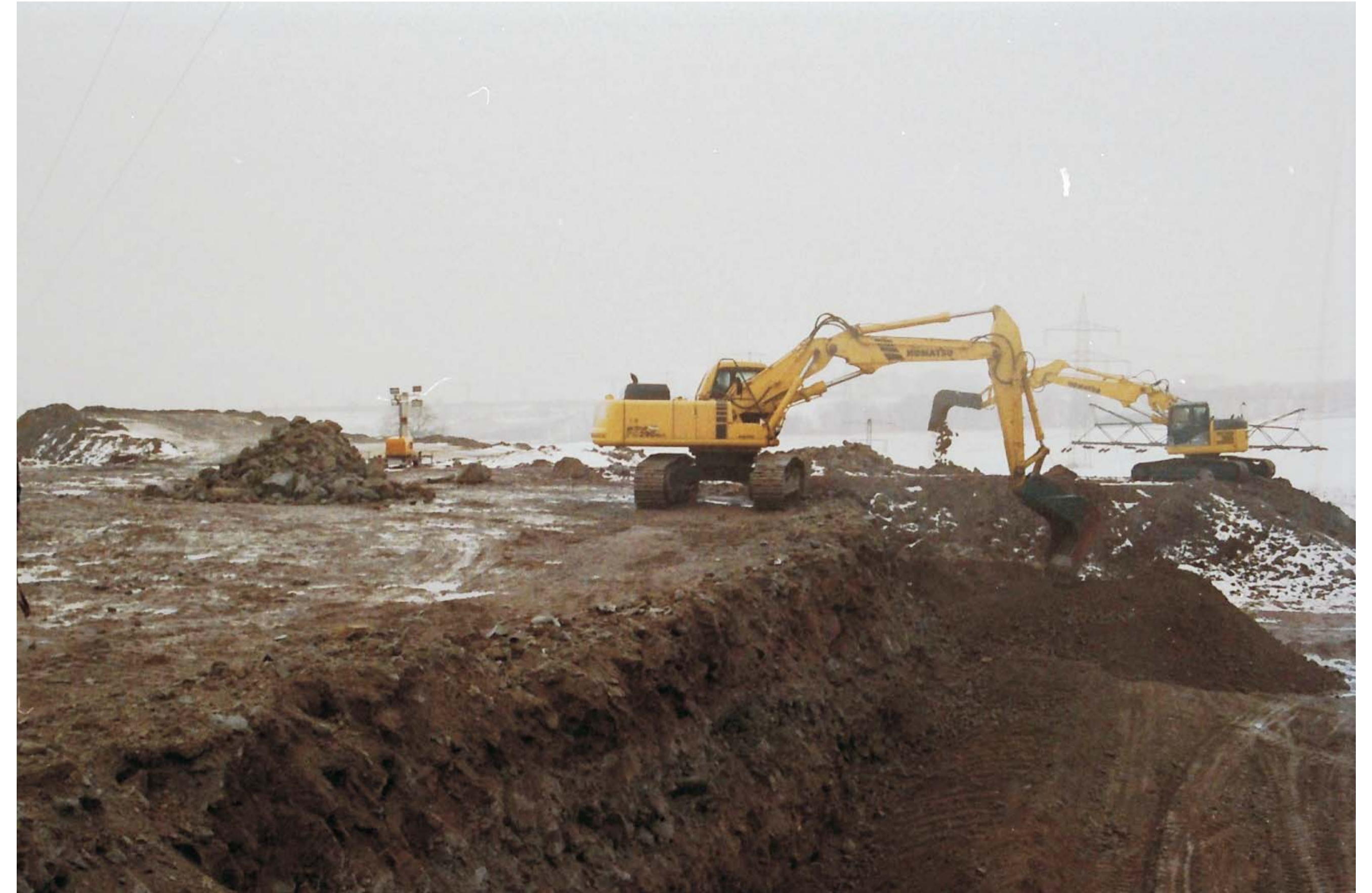
450.000 m 3 Tunnelaushub gesiebt Siebschaufel: 2x B44-1500-100 S - Bagger: Komatsu Pc290
