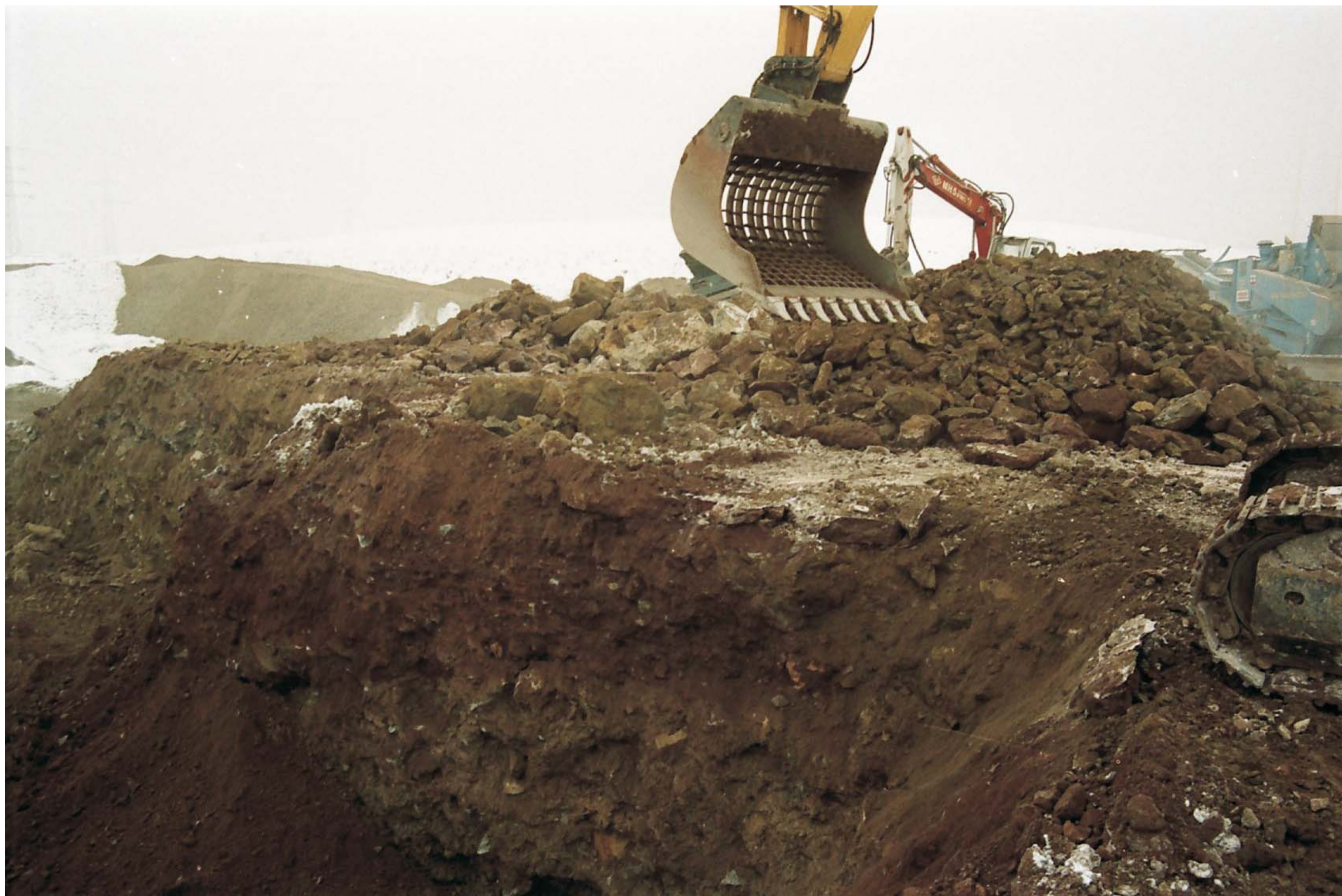
450.000 m 3 Tunnelaushub gesiebt Siebschaufel: 2x B44-1500-100 S - Bagger: Komatsu Pc290
